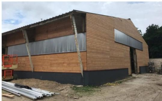
Les travaux du manège du quartier GOUPIL se poursuivent et progressent à un rythme soutenu. Après la dépollution et l'évacuation des matériaux infestés, la reconstruction a débuté par le bardage extérieur et la pose de la toiture. Les travaux intérieurs débutent par les aménagements propres à tous les manèges : pare-botte d'abord et réfection de la piste ensuite.
