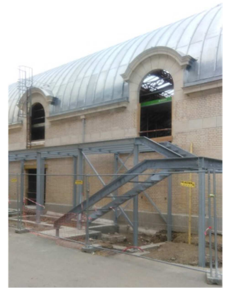
Accès tribune assise, côté infirmerie humaine
